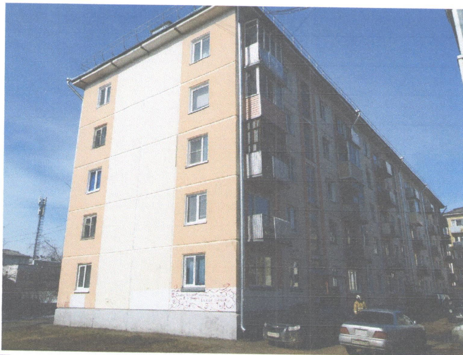
Рис. 1. Пятиэтажное здание, которое подвергалось динамико-геофизическим испытаниям.
